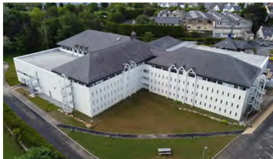
Le bâtiment des Archives Départementales des Côtes-d'Armor à Saint-Brieuc à l'issue des travaux d'extension en 2024.
