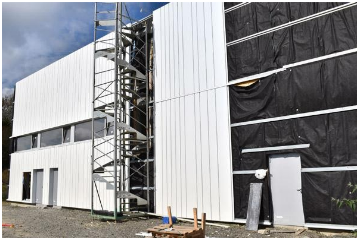
Extension sud : la pose du bardage par-dessus l'isolant
