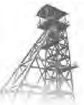
Les *chevalements* (ici le chevalement du puits de la prairie) permettent de remonter les blocs à la surface après extraction. Le treuilliste, situé dans *la cabane du treuil* (à gauche du chevalement), dispose de codes afin de correspondre avec le fond (« code sonnette » avec un téléphone). Quand les ouvriers du fond lui font signe de remonter le bloc, il déclenche le mécanisme du treuil.
