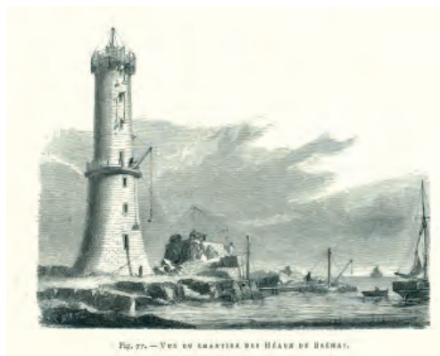
Cote : Bi non coté (AD 22). Détail d'une planche représentant les travaux sur le phare des Héaux de Bréhat, dans Les Travaux publics de la France - tome cinquième : phares et balises, sous la direction de Léonce Reynaud. Date : 1883.
