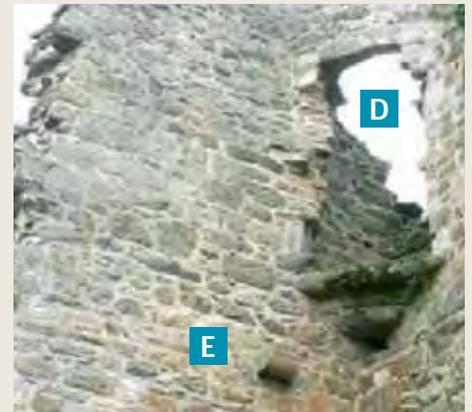
**Corbeau :** pierre, pièce de bois ou de métal, de section verticale carrée ou rectangulaire, partiellement engagée dans un mur et portant une charge dans sa partie saillante.
