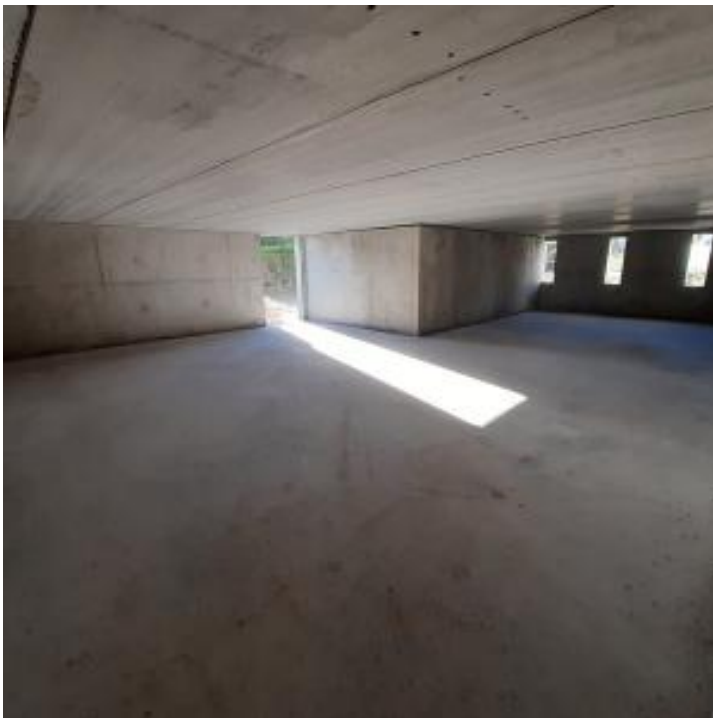
Extension sud, vue du futur magasin climatisé destiné aux photographies
