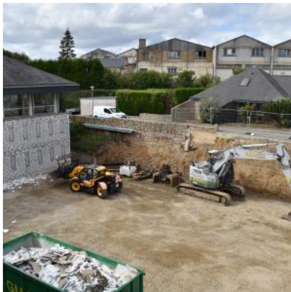
Un décaissement a été réalisé sur la partie sud.
